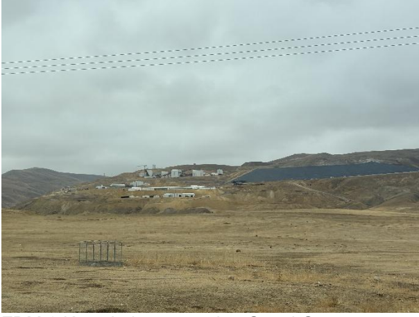
ZDM-3 Kuyu Lokasyonundan Genel Görünüm
